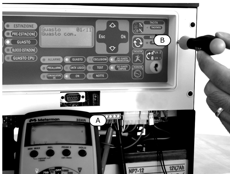
Kuva 33 - Jännitteen säätäminen
