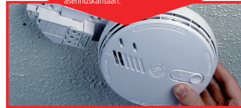
Varoittimen asennus käytävälle ja porrastasanteille
